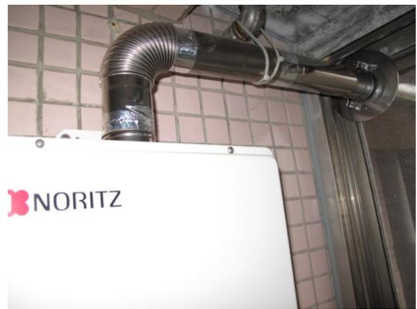
瓦斯排廢氣放軟管改成右圖之白鐵硬管 (圖 1) 目前市面上之排放管大部份如上圖示
