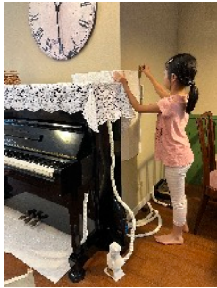
照片10： 鋪設隔音棉
