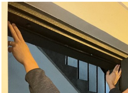
照片12： 將隔音膠條固定於門框上側
