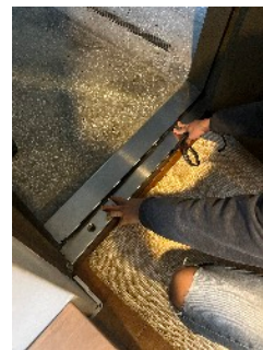
照片13： 將隔音膠條固定於門框下側
